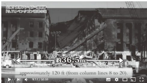
図1 (E Section 崩壊後)
