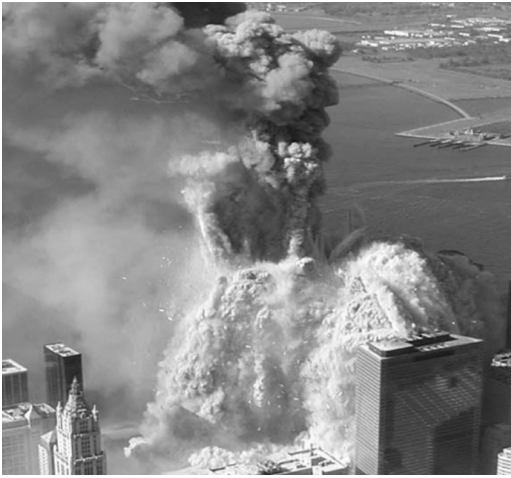
図4 1号棟（北棟）崩壊の様子 9)
